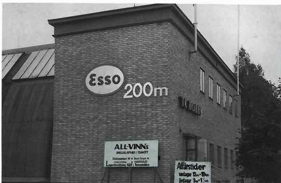
Fasaden på den gamla tennishallen på Västeråsvägen.
